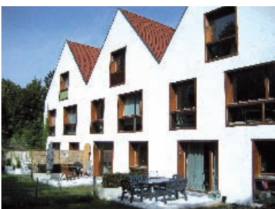
Die Freifläche im Süden gliedert sich in Mietergärten und in einen allen Bewohnern zugänglichen Garten
