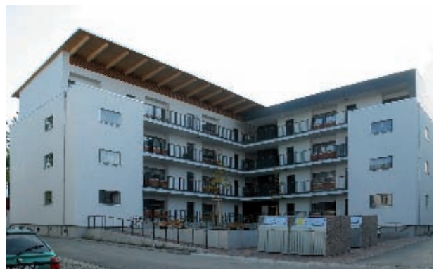
Zeulenroda-Triebes, Aumaische Straße Barrierefreies Wohnen für Generationen Bauherr: AWG "Solidarität" Zeulenroda e.G. Architekt: thoma architekten, Zeulenroda-Triebes
