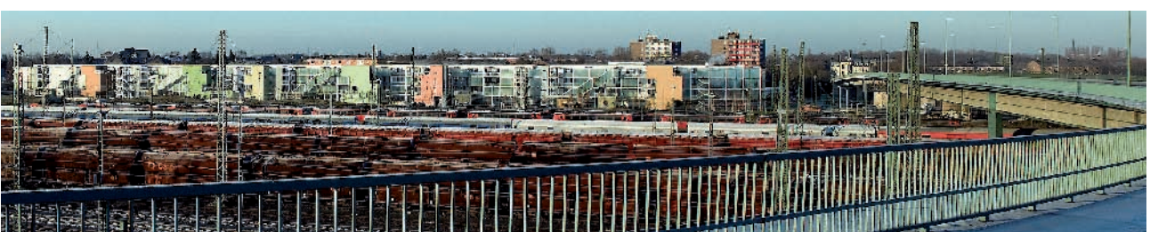
Lifting für den ehemaligen Containerbahnhof
