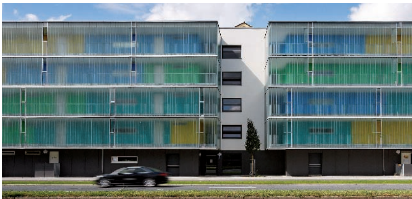
Von der erzielten Lärmabschirmung und damit auch dem Schutz vor Staub und Abgasen profitiert das gesamte Wohnquartier
