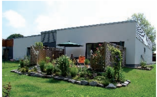
Zwickau, Südstraße Mietwohnungen, Reihenhausbebauung Bauherr: Zwickauer Wohnungsbaugenossenschaft e.G. Architekt: HMB Ing.gesellschaft für Tragwerksplanung, Zwickau
