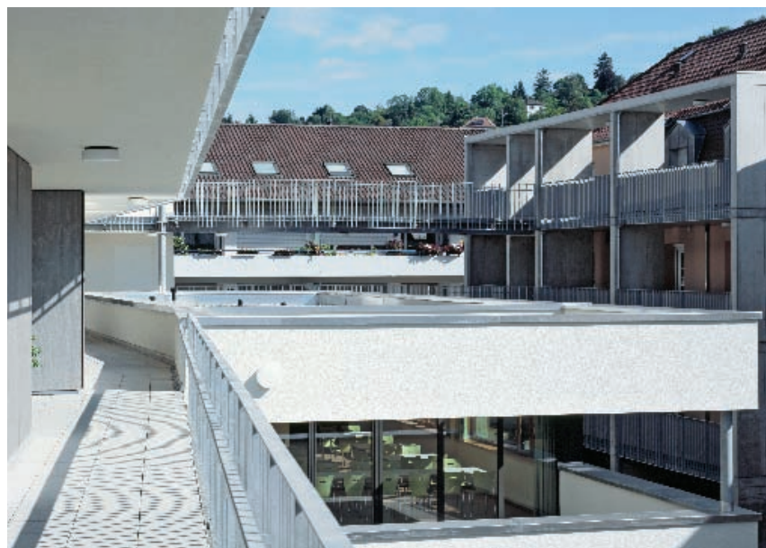
Laubenganganlagen und Stege verbinden den Neubau mit dem Bestandsgebäude
