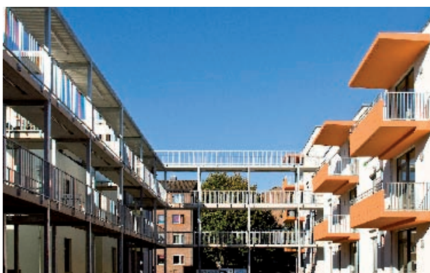
Alle Wohnungen sind barrierefrei: Mietwohnungen, Gruppenwohnungen, Wohngruppen mit Pflegewohnplätzen, Wohnungen zur Übergangspflege, Wohngruppe für demenzkranke Menschen
