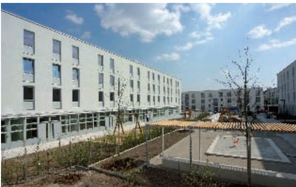
München, Messestadt Riem Mietwohnungen im Geschossbau und Kita Bauherr: GEWOFAG, München Architekt: Herzog und Partner, München
