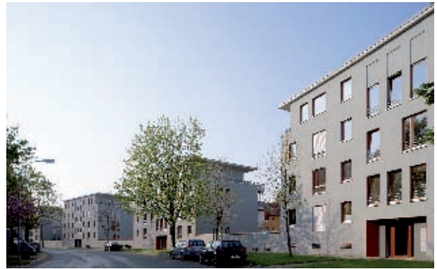
Bochum, Immanuel-Kant-Straße Eigentumswohnungen im Geschossbau Bauherr: VBW Bauen und Wohnen GmbH, Bochum Architekt: Rübsamen + Partner, Architekten BDA, Bochum
