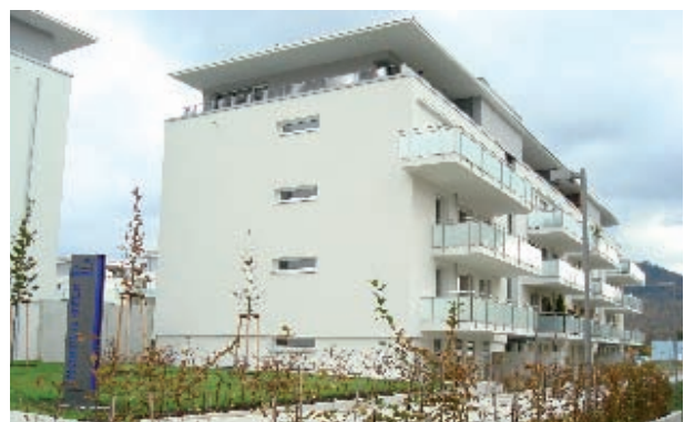
Jena, Altenburger Straße, Merseburger Straße, Naumburger Straße Neubau Wohnanlage "Nordlichter" Bauherr: Wohnungsgenossenschaft "Carl Zeiss" e.G., Jena Architekt: pbs Architekten, Leipzig
