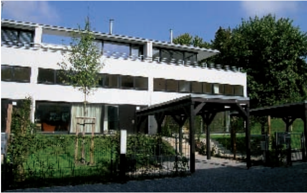
Dresden, Reichenbachstraße Atrien- und Atelierhäuser am Beutlerpark Bauherr: Petersen Immobilien GmbH, Dresden Architekt: Architekten Körnerweg, Dresden
